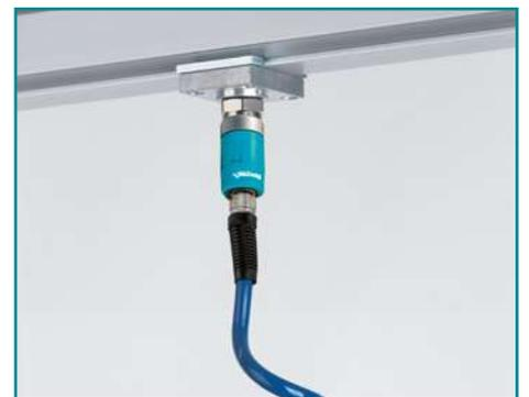
Fertig montierter Druckluftanschluss mit Sicherheitskupplung und Spiralschlauch.
